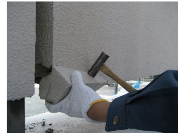
脆弱部はつり・鉄筋防錆処理・プライマー塗布
