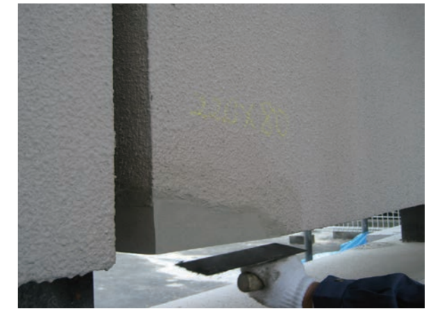
充填材の充填・仕上げ
