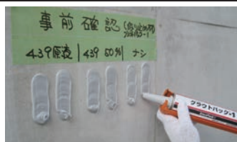
仮止めシールのテスト施工
