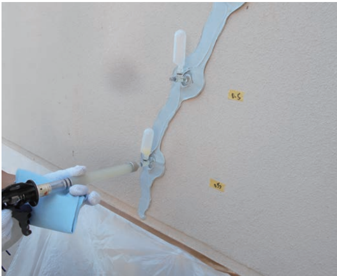
建築構造物 改修 外壁塗装面
