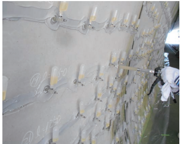
土木構造物 改修 トンネル内壁
