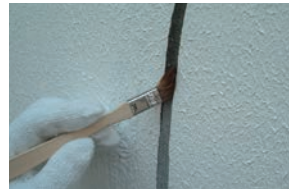
ひび割れ充填のプライマー用途
