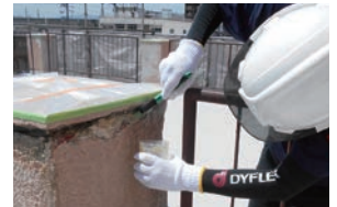
欠損部のプライマー用途 (SK モルタル)
