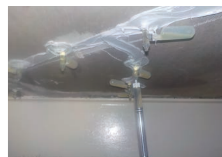
床版ひび割れ注入
