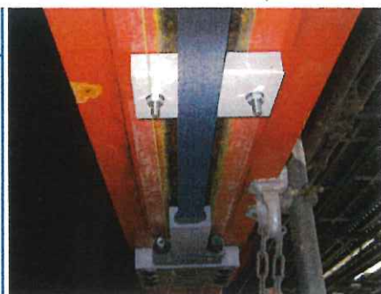
アウトプレート工法によるひび割れ制御およびたわみ回復効果
