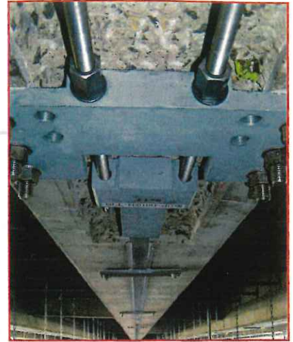
アウトプレート緊張装置
