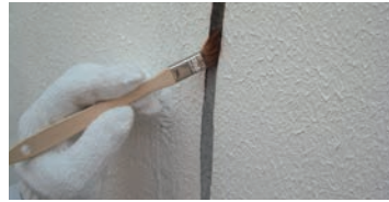
5. プライマー塗布
